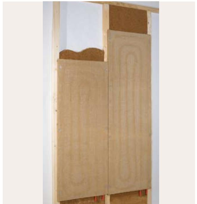
So kann der Wandaufbau aussehen, wenn die Wandheizung in die Innendämmung integriert wird.
