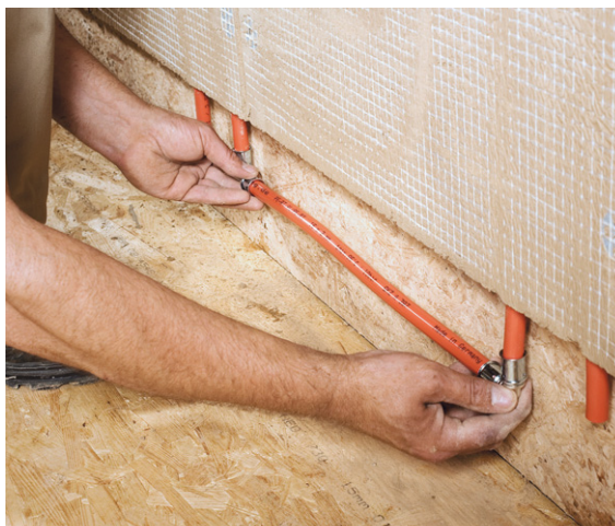
2 Die Klimaelemente werden mit einem Metallverbundrohr und speziellen Presswinkeln verbunden.
